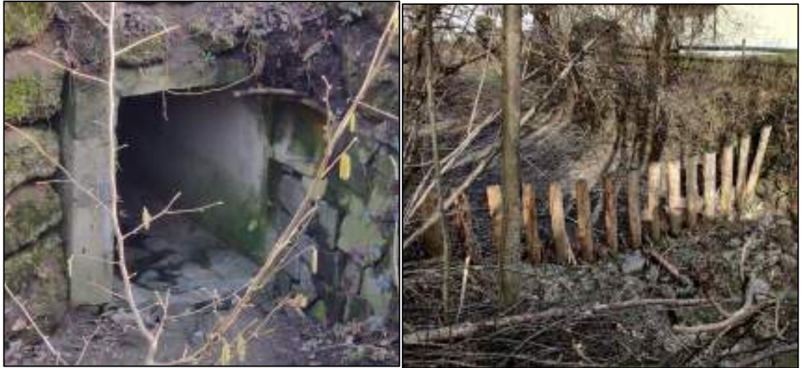
Abbildung 25: Einlaufsituation Wissersdorfer Graben mit Rechteckdurchlass und Wildrechen
