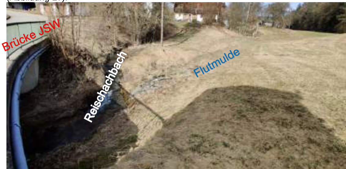
Abbildung 17: Brücke über den Reischachbach - Josef-Straubinger-Weg
