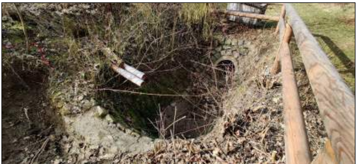
Abbildung 45: Rückhaltebecken Wiesweb aktuell
