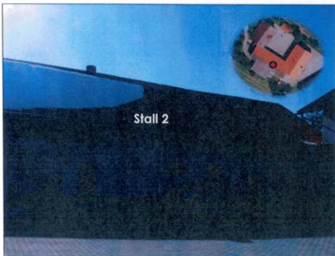
Abbildung 8: Abluftkamin am Stall 2
