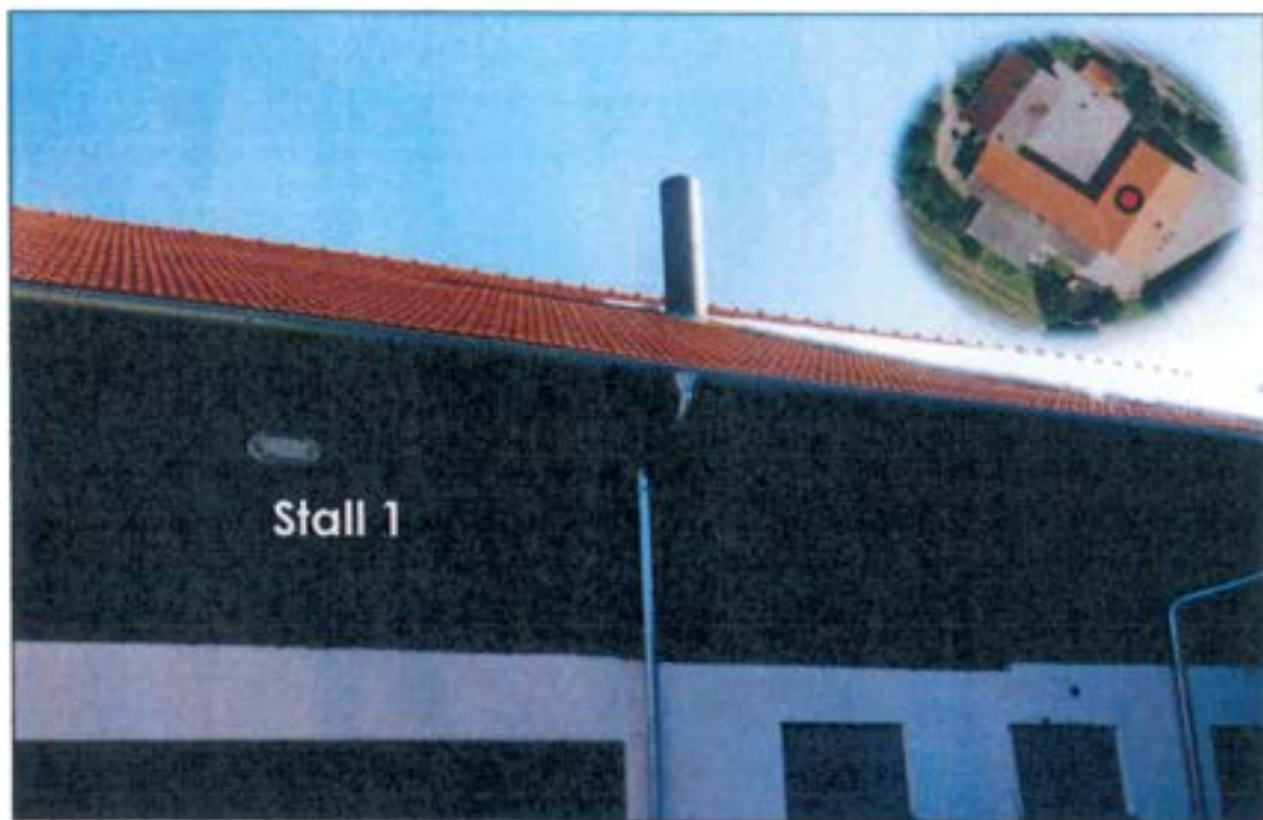
Abbildung 7: Abluft an der westlichen Dachfläche des Stall 1
